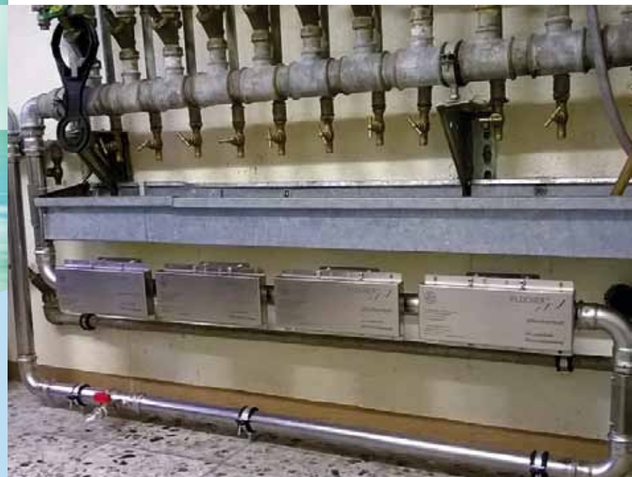
Montagebeispiel: plocherkat in Reihe montiert
